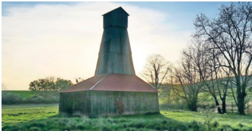
À l'entrée du village en venant de Nancy, cet abri en bois est un sondage d'extraction à partir d'eau injectée à 200 m de profondeur dans la couche de sel de 250 millions d'années av. JC. L'eau saturée en sel, appelée saumure, est évaporée dans la saline située juste à côté, pour produire le sel de table de consommation courante.
